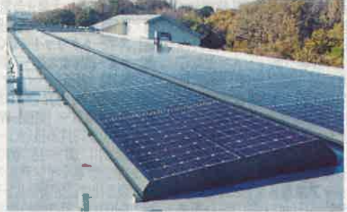
陸屋根で防水層を傷つけないアンカーレス架台
